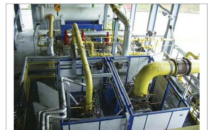
Рис. 3. Винтовые компрессоры первой и второй ступеней сжатия: справа винтовой компрессор 9ГВ, слева – 6ГВ
