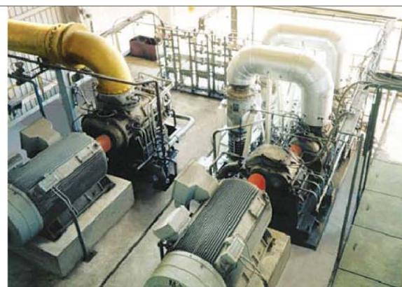
*Рис. 1. Трехступенчатая винтовая компрессорная установка «сухого» сжатия 965ГВ200/19С У2 (поставка 1996 г.)*
