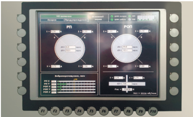
Рис. 6. Панель оператора ШУ ЭМП
